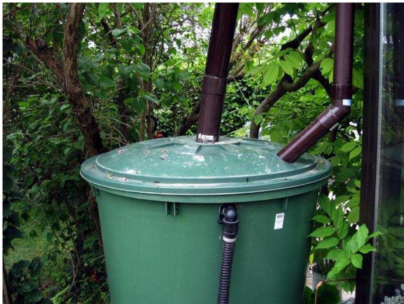
**Figure 5** Détail du collecteur de la véranda et du toit, arrivées séparées.
