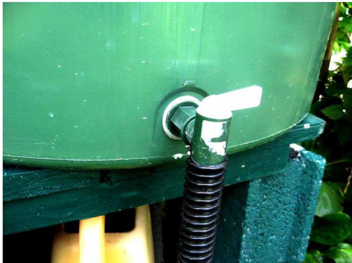
**Figure 8 Vanne de sortie en bas du tonneau.**
