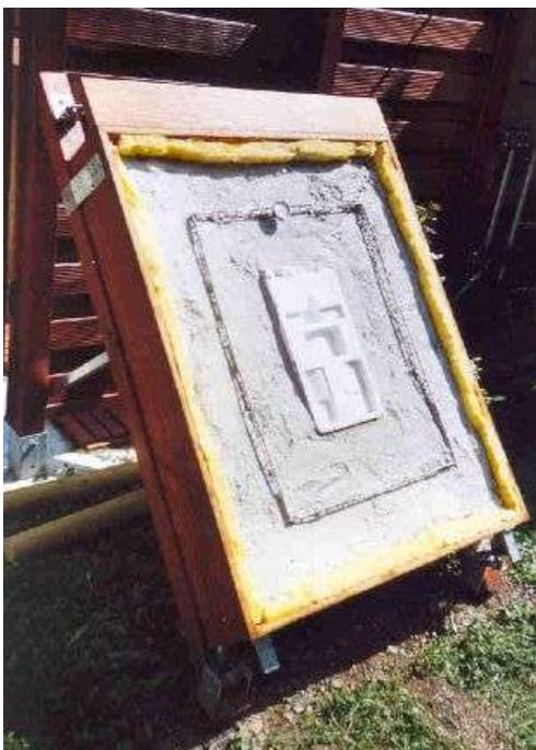
Ensuite, il faut couler 3 sacs de 40 Kg de béton, ceci sur une surface bien plane pour éviter l'écoulement.
